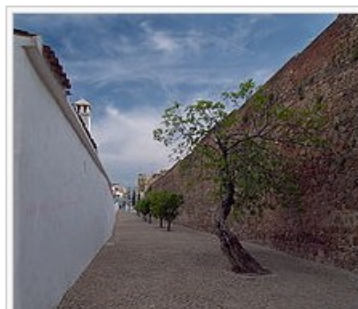
Muralha junto à Rua dos Muros de Baixo; ao fundo situava-se a Porta do Postigo.
